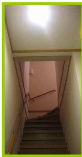
天井が高い階段に使用
